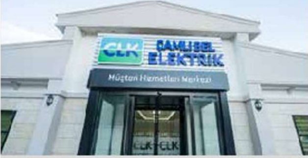
CLK Çamlıbel Mehmetpaşa Hizmet Binası
