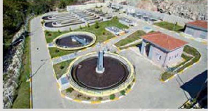
Dursunbey Atıksu Arıtma Tesisleri
