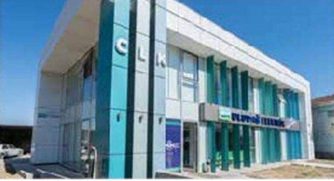
CLK UEDAŞ İnegöl Hizmet Binası
