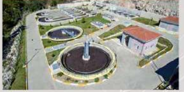
Dursunbey Atıksu Arıtma Tesisleri
