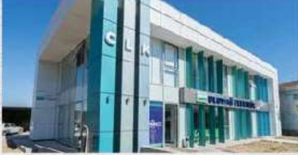
CLK UEDAŞ İnegöl Hizmet Binası
