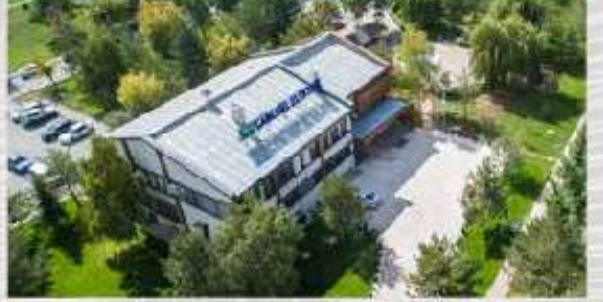
CLK ÇEPSAŞ Genel Müdürlük Binası
